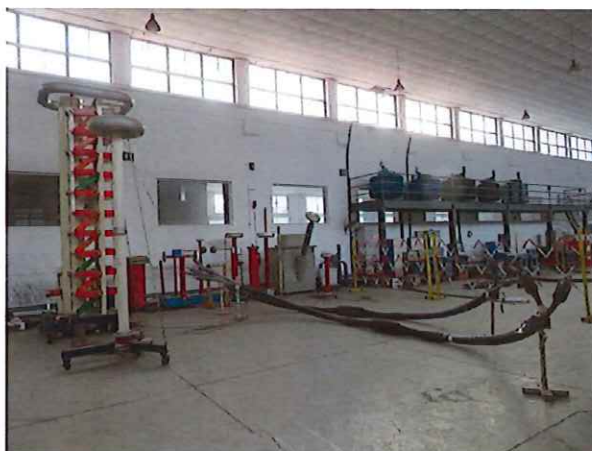
G3: 冲击电压试验 Impulse voltage test
