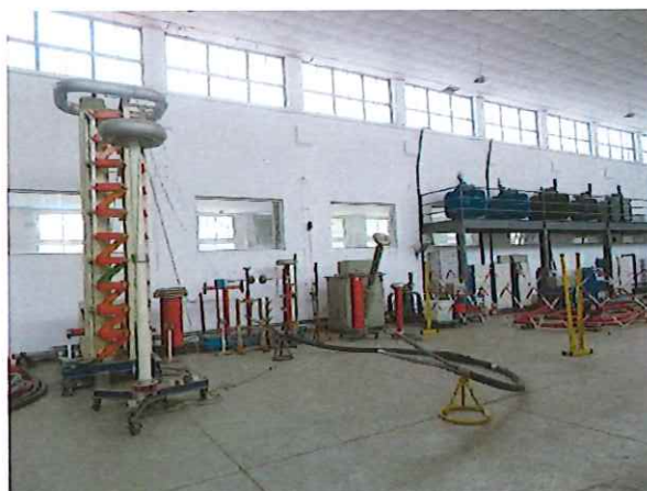
C3: 冲击电压试验 Impulse voltage test
